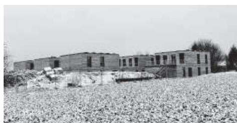
nen. Teilabnahmen dazu sind bereits erfolgt. Die Photovoltaik-Anlagen zur Eigenversorgung, vorwiegend für den Betrieb der Luft-Wärme-Pumpe, sind auf den Dächern installiert, zudem der Löschwassertank eingebaut. Die Arbeiten an den Außenanlagen konnten beginnen, und im Technikmodul werden die notwendigen technischen Anlagen eingebaut.
