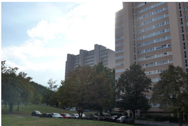
Abbildung 24 - Grundsätzlich durch Überhitzung gefährdet - Gebäudebestand der 60er und 70er Jahre (Bild: faktorgruen).
