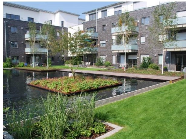
Abbildung 130 - Auf Tiefgaragen lassen sich hochwertige Freiräume entwickeln. Die Aufbauhöhe sollte so gewählt werden, dass Baumpflanzungen möglich sind (Bild: Optigrün international AG).
