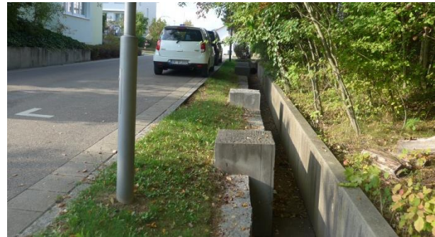
Abbildung 106 - Teilelement des nachhaltigen Regenwassermanagements in Diezenhalde (Bild: faktorgruen).
