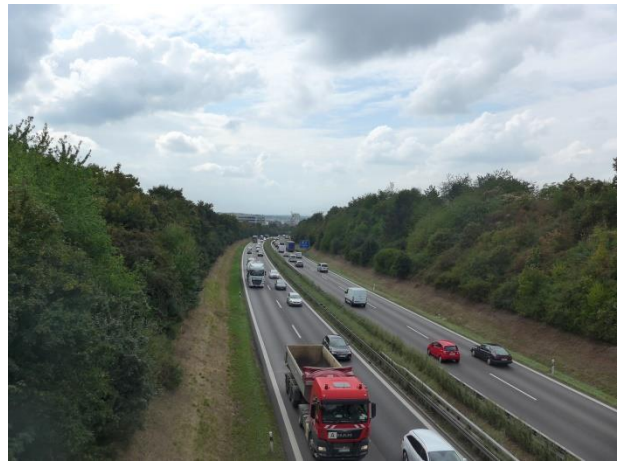
Abbildung 33 - Die Autobahn stellt eine starke Barriere zwischen Böblingen und Sindelfingen dar (Bild: faktorgruen).
