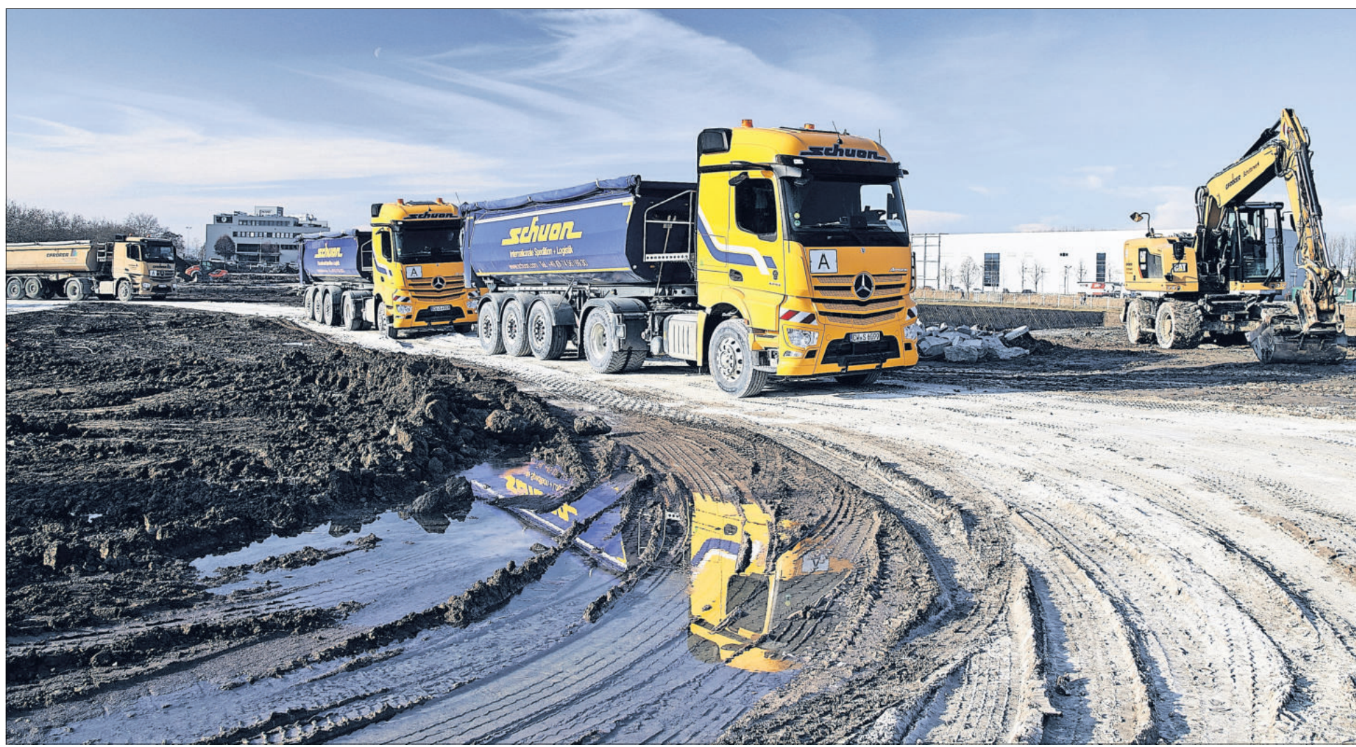
Actros 1846 LS im Transporteinsatz beim Erdaushub der Großbaustelle des Projekts Neubau Flugfeldklinikum in Böblingen
